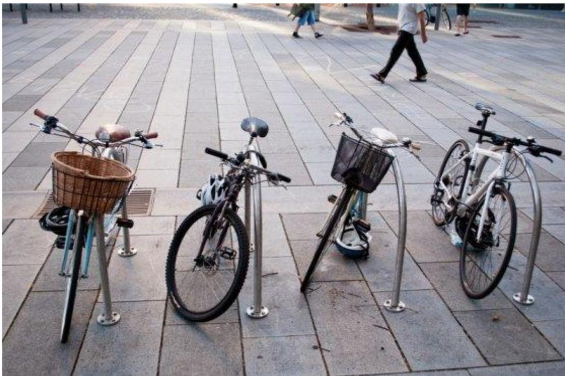
2) **Избегайте конструкций, удерживающих велосипед за одно колесо!!!** Велосипед должен касаться стойки рамой, а не колесом. Это предохраняет велосипед от падения при выворачивании колеса, если кто-то заденет велосипед. Такое выворачивание может привести вплоть до поломки колеса - появление восьмёрки.
